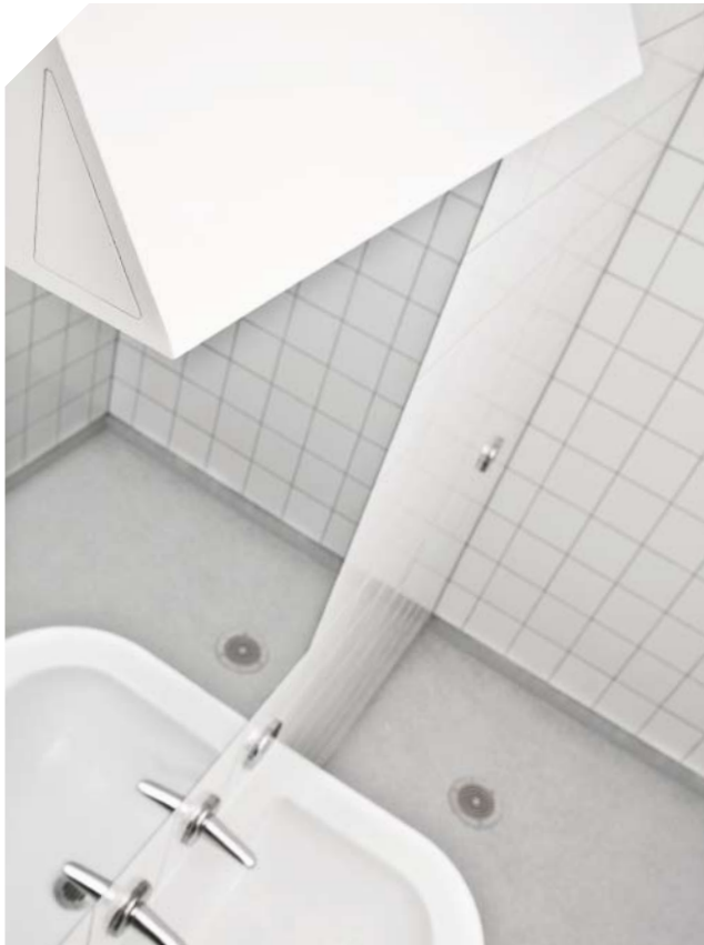
Til venstre: Håndvask med sensorer og indbyggede amatører, der skræner lidt. Her over: Skrå lyskasse. Her under: Skrå skabslåge. Indbygget dørhængsel. Inderside af dør med håndtag. Yderside af dør med håndtag.
